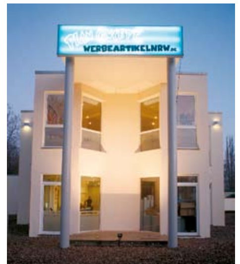
Für die Zukunft gut aufgestellt: Renovierter Firmensitz in Essen.
